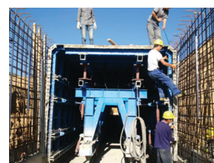
Dali közhasznú alagút
