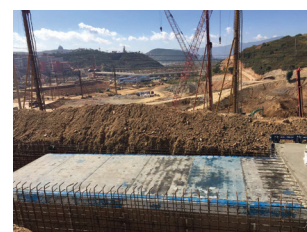
Dali közhasznú alagút
