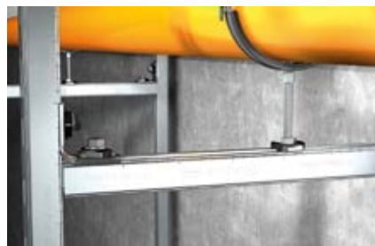
Csővezetékek keretszerkezeteken
