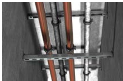
Csőrögzítések folyosókon
