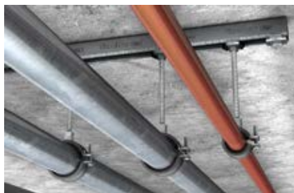
Csörögzés szerelősínnel
