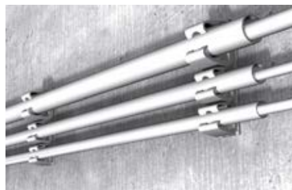
Műanyag szigetelőcsövek rögzítése
