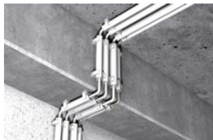
Műanyag szigetelőcsövek rögzítése
