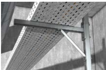
Kábeltálcák rögzítése
