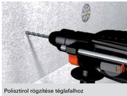
Polisztirol szigetelőtábla rögzítése beütőszereléssel
