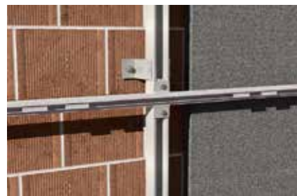
Részlet: SPH rögzítése betonba
